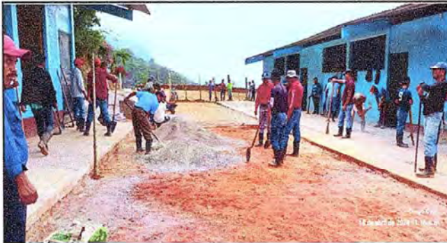
Foto 3: En esta fotografía se observan los padres de familia trabajando para poner el entortado en el corredor de los módulos.
