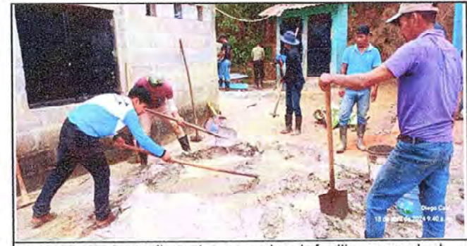
Foto 6: En esta fotografía se observan padres de familia preparando el material para repellar la pared de la cocina.
