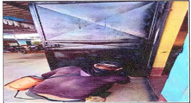
Foto 2: En esta fotografía se observa el lijado y pintado de las puertas que se encuentran en mal estado.
