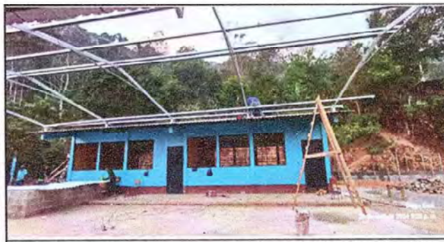
Foto 5: En esta fotografía se observa la colocación de costaneras del corredor del módulo I y II.
