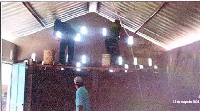
Foto 1: En esta fotografía se observa el repello de la pared del módulo III.
